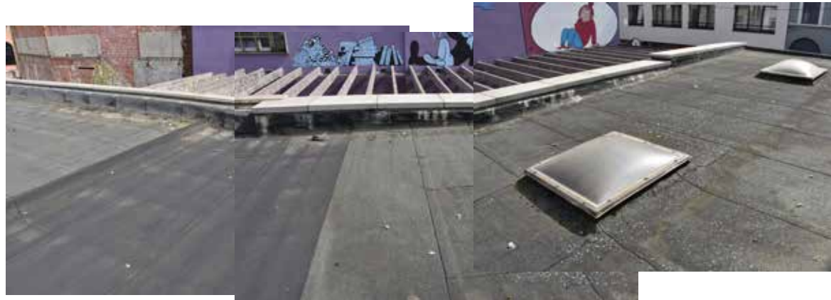
Toiture plate du bâtiment Abattoir construit par la Ville de Bruxelles (année inconnue) (photo 2021)
