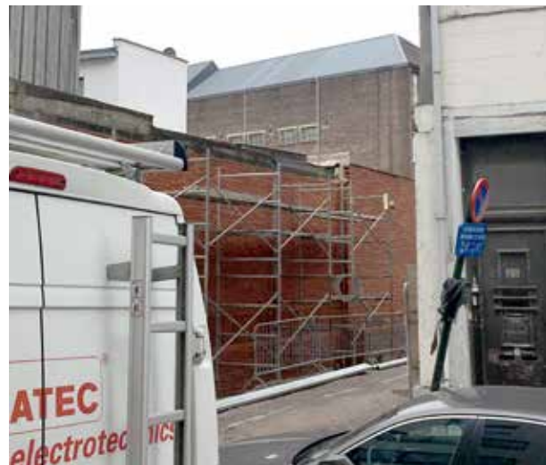
nouveau parement placé en 2018 - chantier Tour à Plombs (photo 2018)
